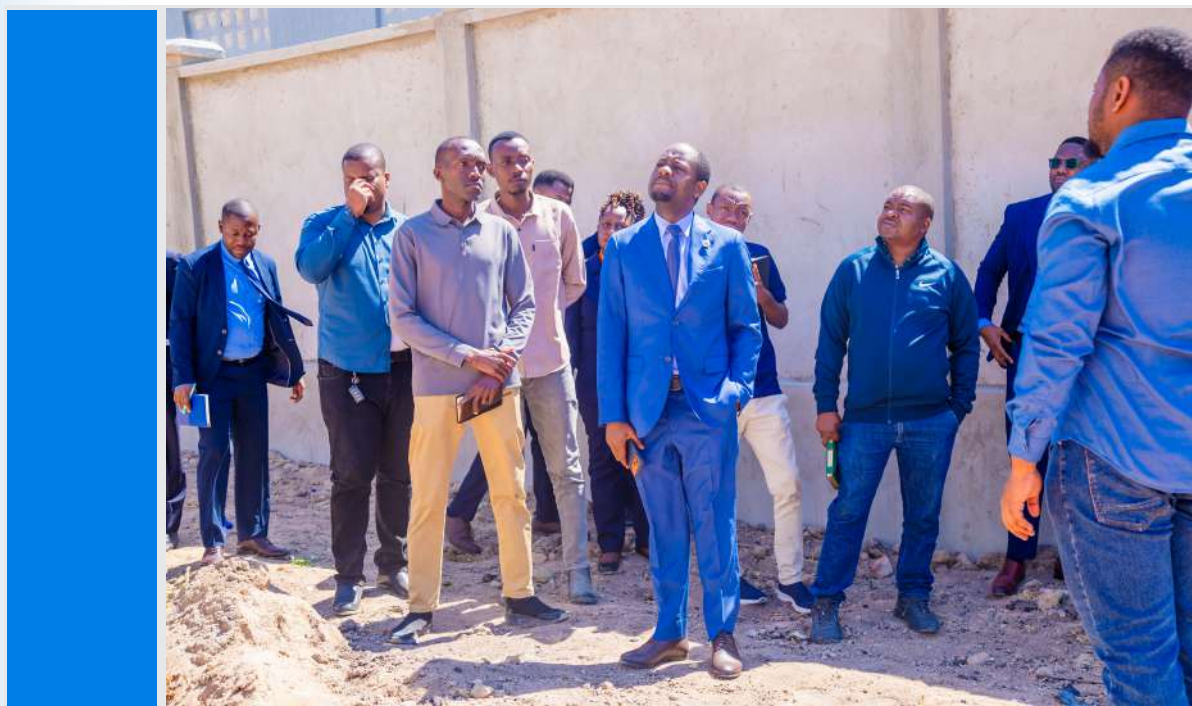
Naibu Mwanasheria Mkuu wa Serikali, Mhe. Samwel M. Maneno akikagua maendeleo ya mradi wa ujenzi wa jengo la Ofisi ya Mwanasheria Mkuu wa Serikali Mtumba Jijini Dodoma.
